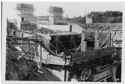
Beton- und Schalungsarbeiten
