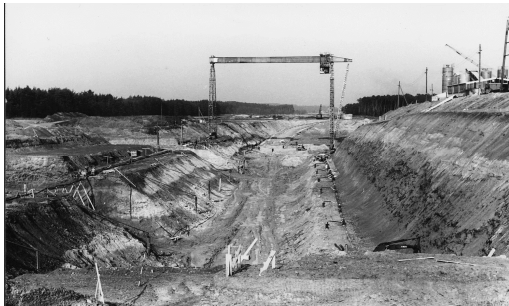
Aushub am Oberhaupt 1968
